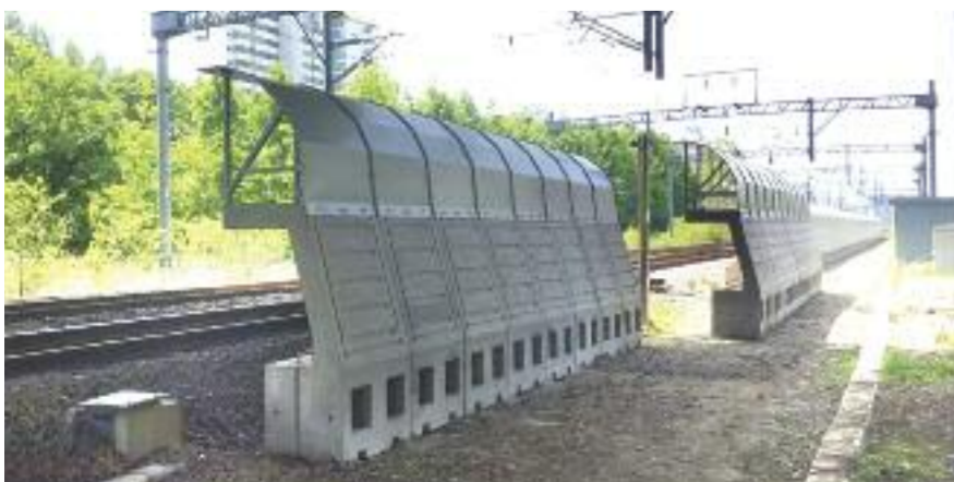
한국철도시설공단과 한국철도기술연구원 공동 개발한 '선로근접형 저상방음벽'.
