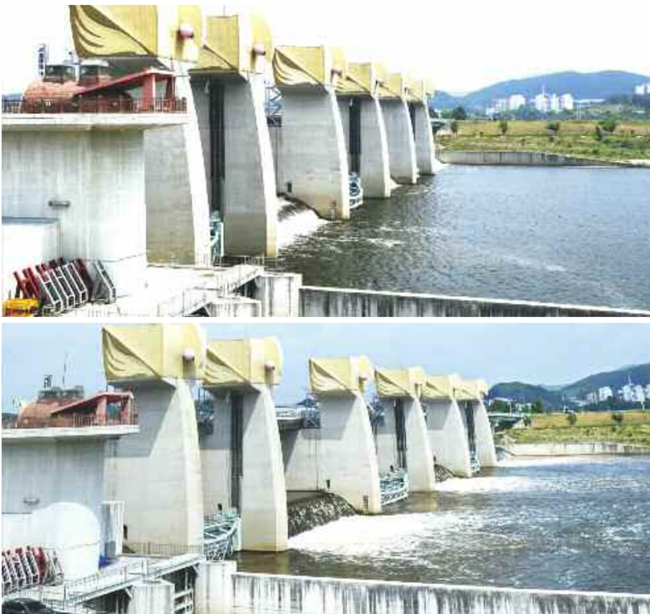
공주보, 수문 개방 전과 후 정부의 4대강 보 개방 방침에 따라 지난 2017년 6월1일 오후 충남 공주시 금강 공주보가 수문을 개방했다(사진 아래). 지난해 8.75ELm였던 공주보의 수위는 완전 개방한 이후 2018년 6월 11일 기준 4.3ELm로 낮아졌다.(위쪽 사진은 수문 개방 전 공주보 모습)
