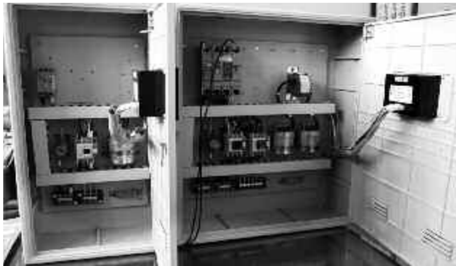
기립전기통신이 개발한 배수펌프판넬. 이 제품은 철재 대신 ABS재질로 만들어져 부식 문제가 없고, SMPC가 외함 도어에 장착돼 편의성과 유지보수성을 획기적으로 개선한 게 특징이다.
